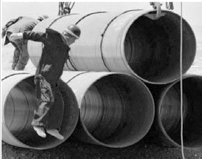
I tubi utilizzati per la costruzione di un gasdotto
