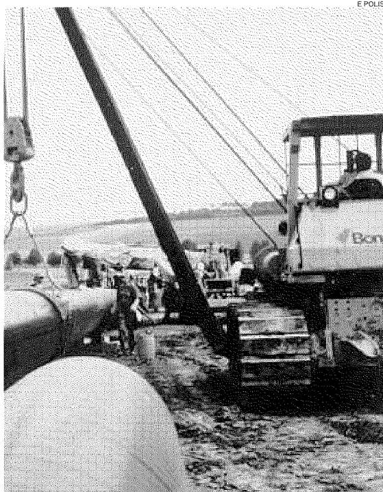
► Metanodotto in costruzione: i lavori partiranno nel 2010
